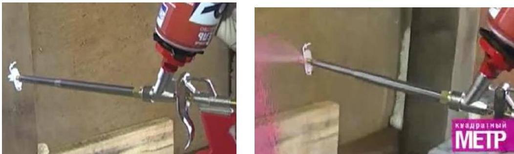
Из аудио-видео дорожки сюжета к передаче «Квадратный метр» следует, что утеплитель находится в баллонах под давлением. Для нанесения утеплителя на поверхность монтажник подсоединяет монтажный пистолет к баллону, снимает распылительную насадку, присоединенную к верхней части баллона, и устанавливает ее на ствол пистолета.
