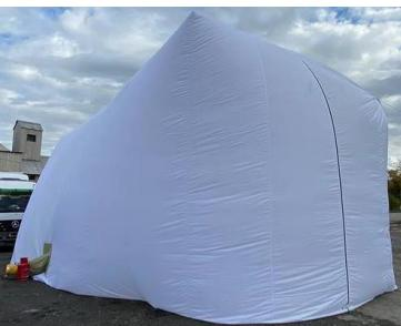
воздухонаполняемая палатка (палатка-чехол) («[\[2\]](#)», см. описательную часть). Эта палатка имеет оболочку, выполненную в виде полотнищ, соединенных между собой с образованием формы палатки
